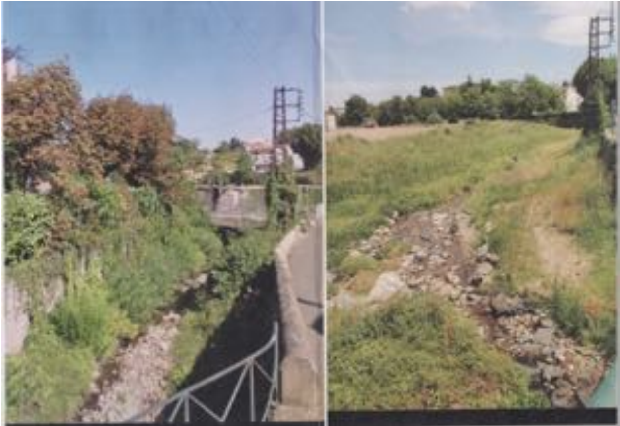
(8) la zone de la passerelle supprimée sur le Langonand ; à gauche il y avait 2 habitations.
